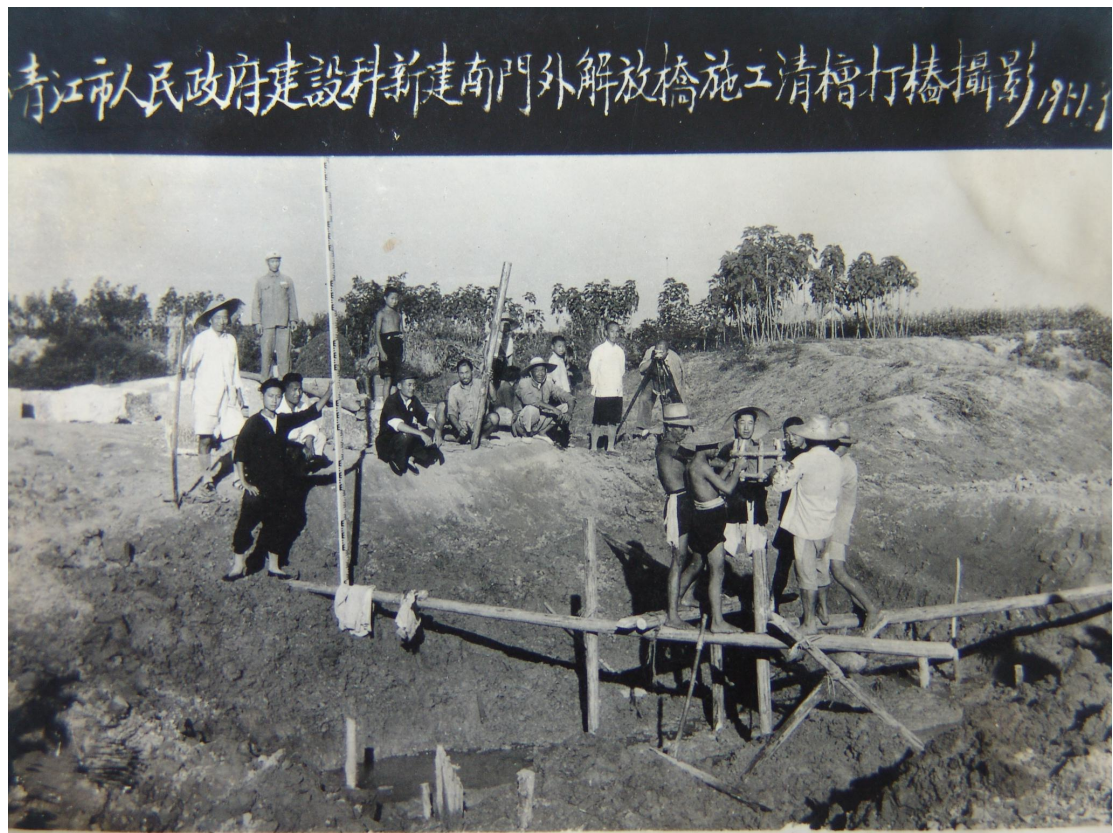
1951年，清江市人民政府建設科新建南門外解放橋施工，清槽打樁攝影。淮安市檔案館藏，檔號：D018-1951-003-0002-0001
